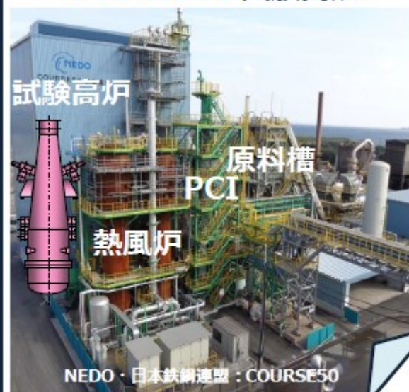
COURSE50 試験高炉
